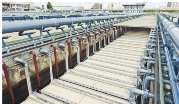
Nhà máy xử lý nước thải
